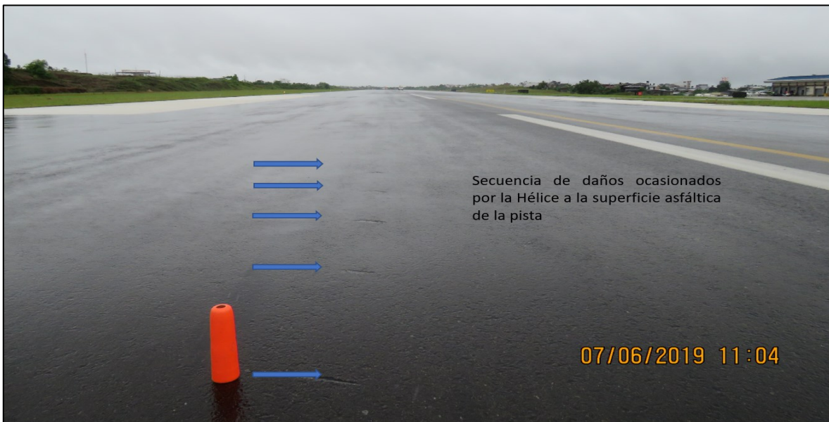
Fotografía No. 5: Marcas dejada por la Hélice en la pista
